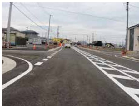
きれいに整備された道路区画線
