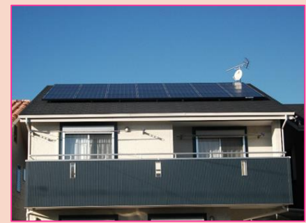
▲家庭用太陽光発電システム
