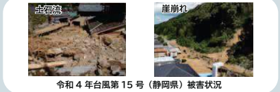
令和4年台風第15号（静岡県）被害状況
