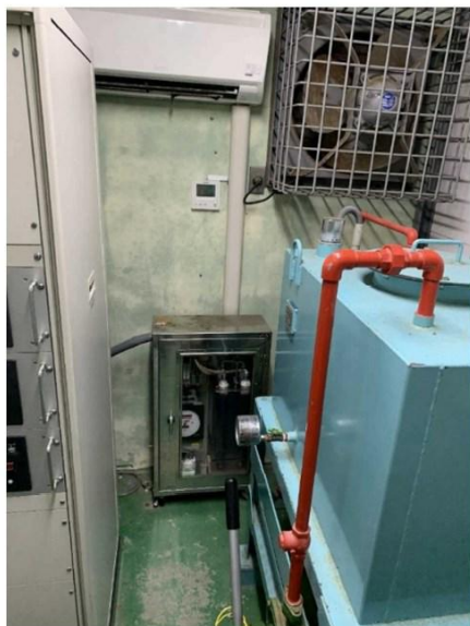
写真4 白砂局舎内の状況
