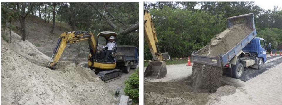
図2 掘削作業(左)及び埋め戻し作業(右)の様子
