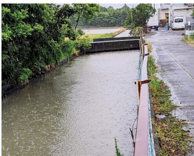
田尻新堀川の満潮時下流付近
