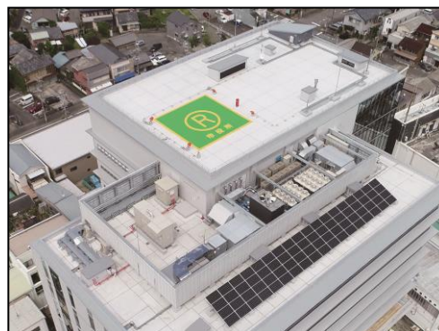
庁舎に太陽光発電設備を導入し 庁内電力として使用
