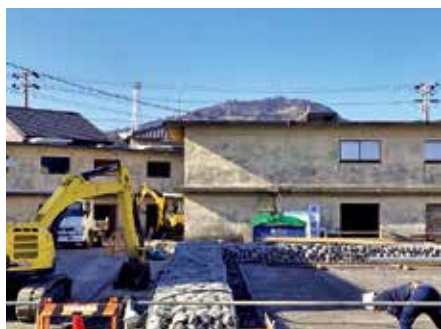
焼津内港の漁具倉庫を活用した ワーケーション施設の工事風景
