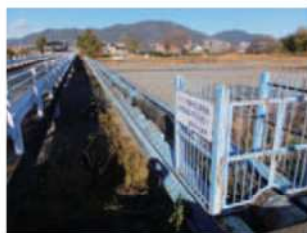
瀬戸川に架かる水管橋
