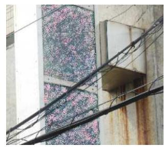
ブラケット下に汚ダレが見られると、内部の取付金具にサビや腐食の可能性がある。
