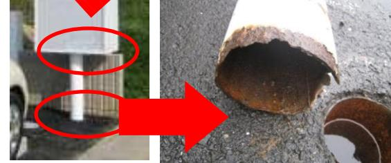
↑柱根元のサビを放置し、倒壊。
