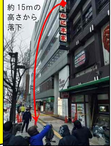
2015年2月、札幌市内の飲食店ビルの外壁に取付けられた看板の一部が落下し、歩道を通行していた女性の頭部に当たり重傷を負わせる事故が発生しました。外壁への取付け部品が腐食したことでの強度低下、強風の影響で落下したものとみられています。
