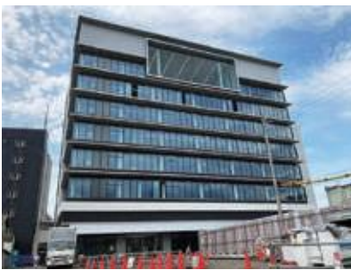
灯台をイメージしたという市役所新庁舎の北側からの外観
