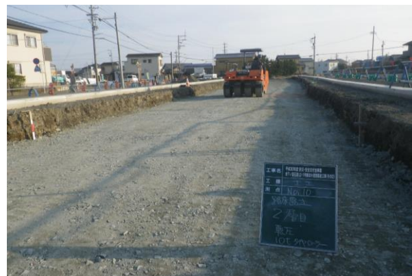
【施工中(路床盛土状況)】
