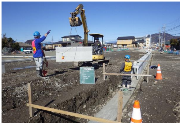
【施工中(側溝据付状況)】
