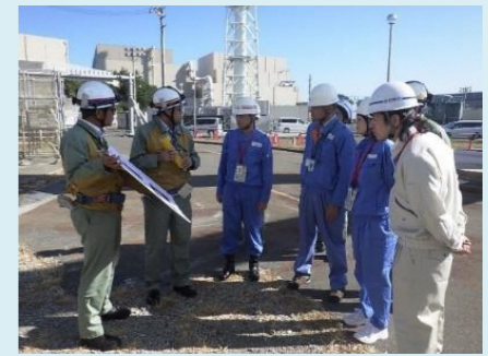
フィルタベント放射線監視強化対策工事点検の様子 (第88回)
