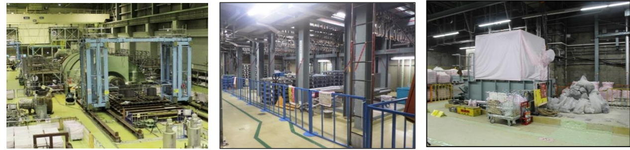
2号機 タービン・発電機の解体工事の状況
