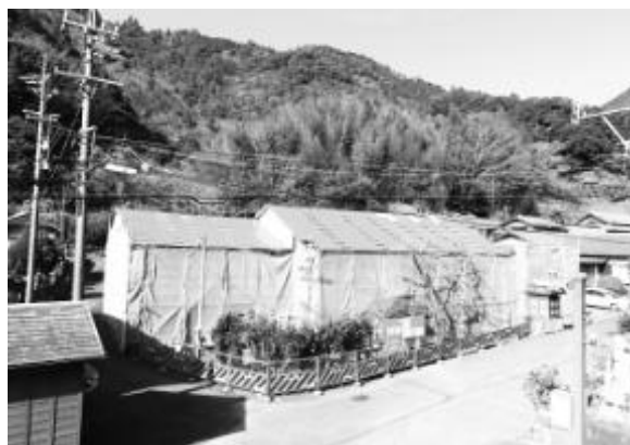
完成に向けて工事が進むビジターセンター
