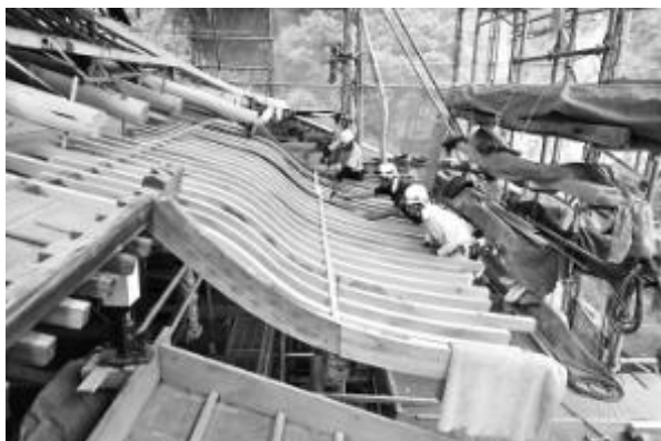
法華寺本堂の修理状況
