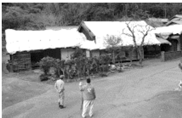
花沢地区ビジターセンター応急修繕後
