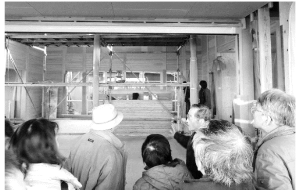
12 月 14 日現地視察「藤守の田遊び伝承館」建設現場
