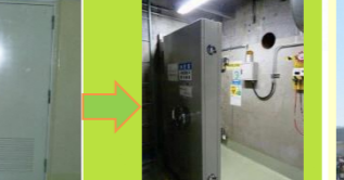
㊋建屋開口部自動閉止装置
