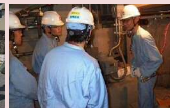
原子力圧力容器ボトムドレン弁電動化 工事点検の様子(第78回)
