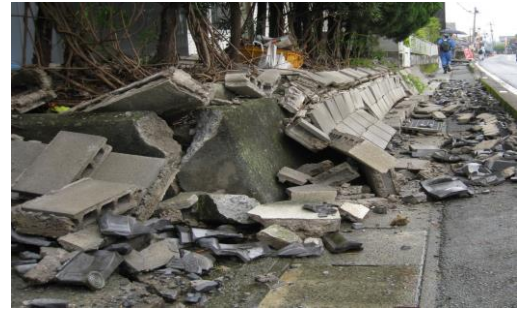
平成28年 熊本地震で倒壊したブロック塀
