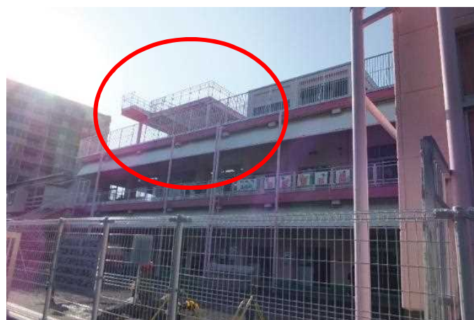
図 15 屋上への避難場所を増築した事例
