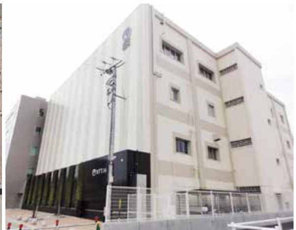
(事例4) 目立たないよう工夫された配管類
