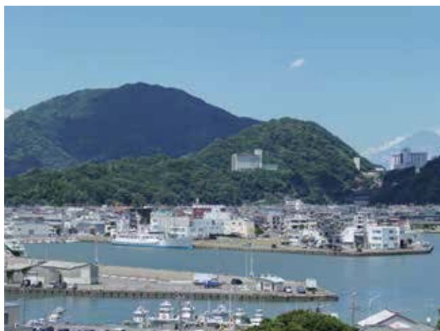
写真 6-28. 焼津漁港（焼津内港地区）
