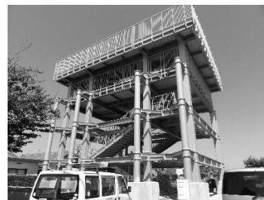
津波避難タワー
