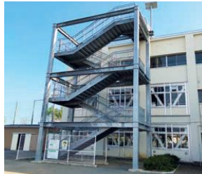
▲津波避難ビル（港小学校）
