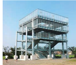
▲津波避難タワー
