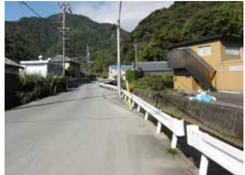
市道当日花沢線の防護柵（ガードレール）
