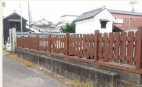
専用駐車場と道路敷地境界への板塀の設置
