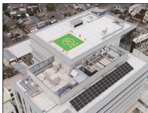
庁舎に太陽光発電設備を導入し 庁内電力として使用
