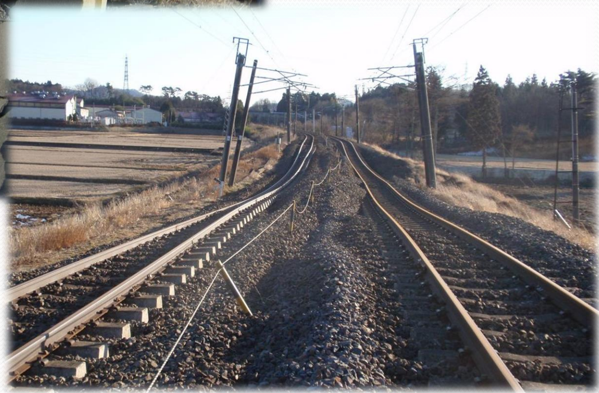
歪んだ線路 傾く電柱
