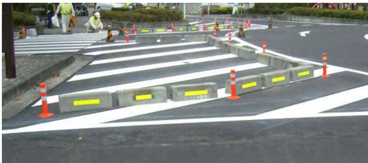
ポストコーン、歩車道境界ブロック
