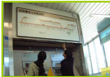
駅舎内の施設についての点検
