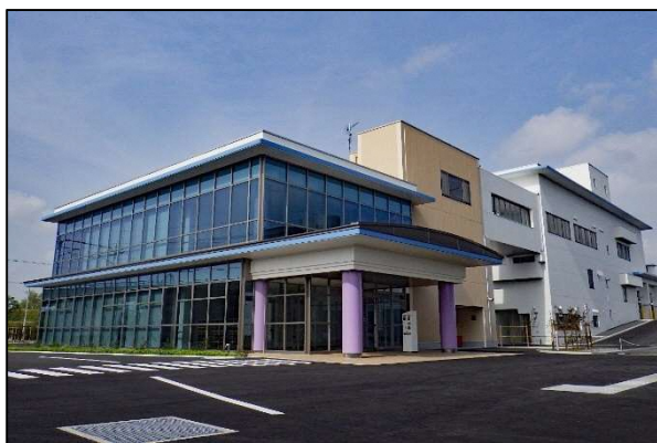
（藤枝環境管理センター）
