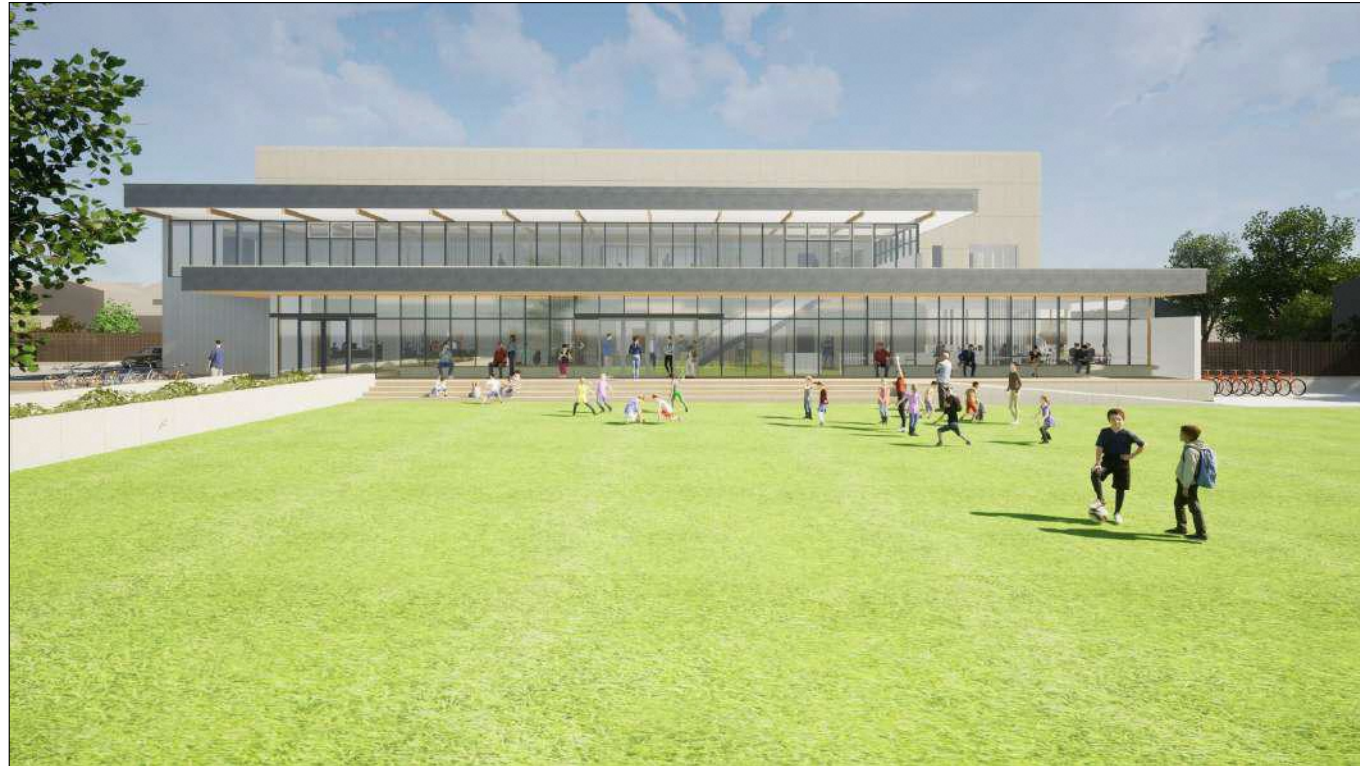
南側外観：広場側に開いた施設。軒を深くして日射遮蔽し、Low-E複層ガラスを採用することで、環境負荷を抑える。
