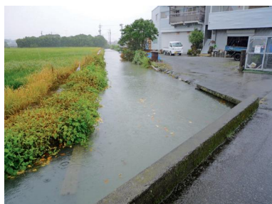
田尻新堀川雨天時状況
