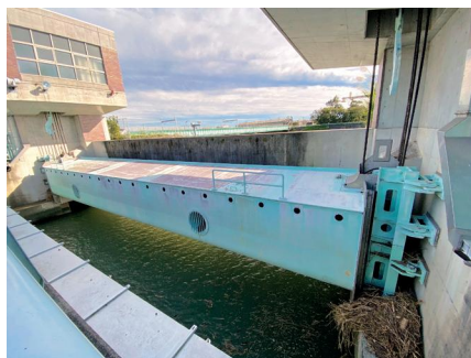
石脇川新水門
