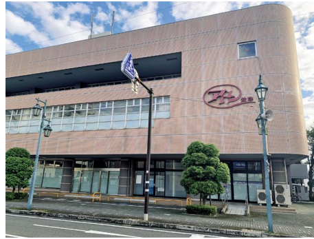
改修工事が進められるアトレ庁舎
