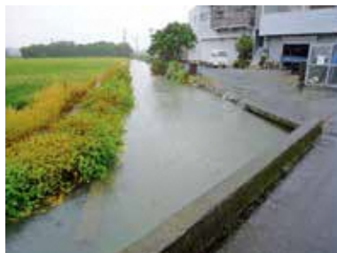
田尻新堀川雨天時状況
