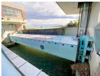
石脇川新水門
