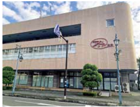
改修工事が進められるアトレ庁舎
