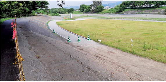
2級河川瀬戸川保福島親水公園 園路・芝生の進捗状況
