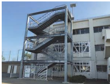
写真-14 津波避難ビル
