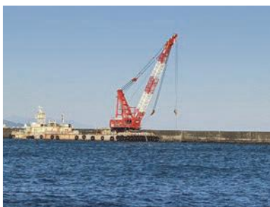
写真-17 焼津漁港 (防波堤の粘り強い化)
