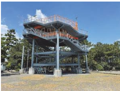
写真-13 津波避難タワー
