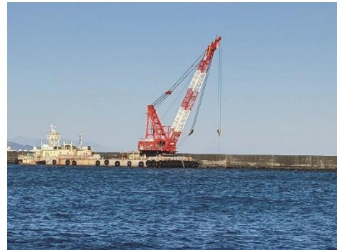
写真-11 焼津漁港（防波堤の粘り強い化）
