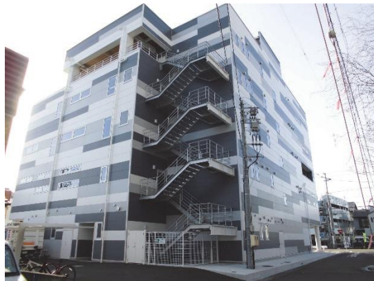
写真-12 指定津波避難ビル（B.B.BOX焼津）
