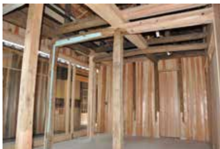
Fig.13 改修後の外便所棟展示スペース
