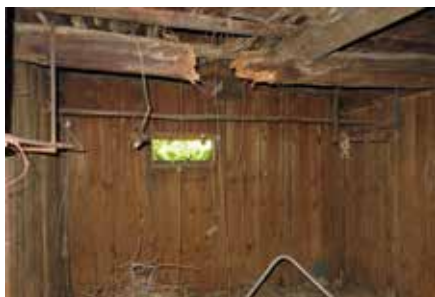
Fig.12 改修前の外便所棟内部
