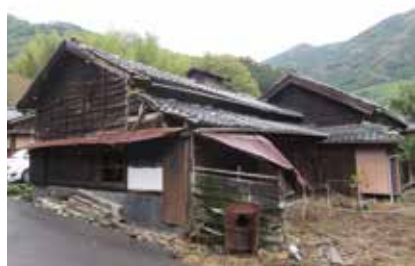
Fig.8 改修前の附属屋
