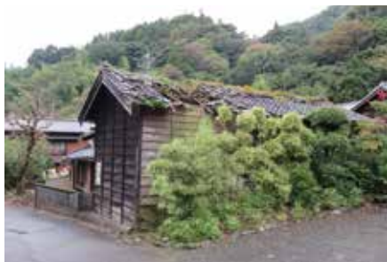
Fig.10 改修前の外便所棟
