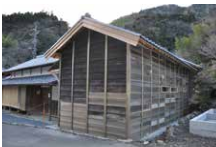
Fig.11 改修後の外便所棟
