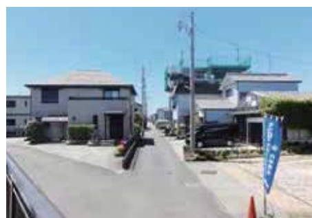
写真 3-46. 住宅街の津波避難タワー
